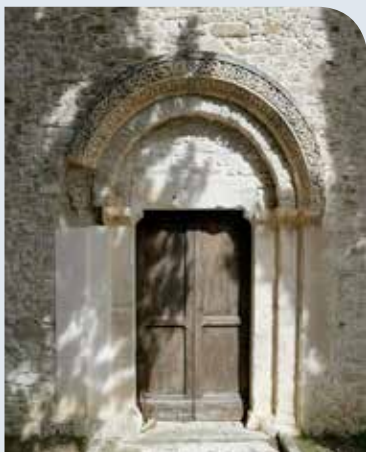
Secondo ingresso sul lato destro della chiesa.
