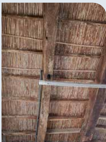
Particolare della copertura lignea e cannuce.
