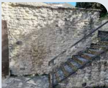
Muro perimetrale della Cisterna.
