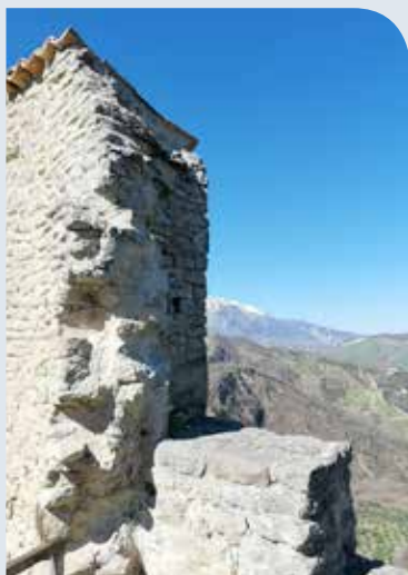
Particolare dell'ingrossamento delle merlature della Torre di Sentinella.
