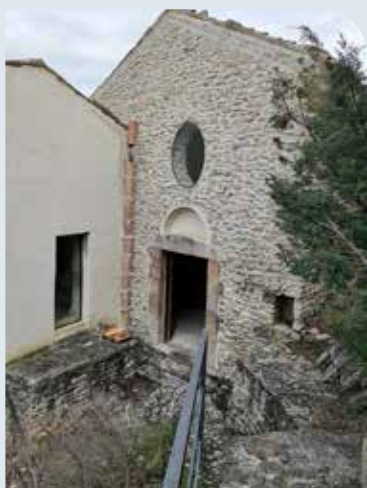
Esterno della Cappella
